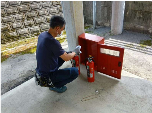
1 * 消火器の点検 1 階
