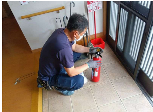
2 * 消火器の点検 2 階
