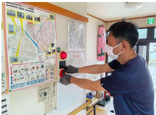
5 * 非常ベルの確認
