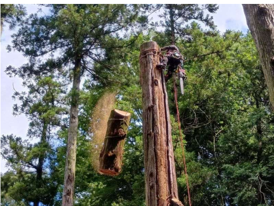
15 * 御神木上部切断完了
